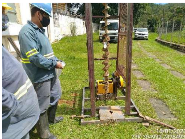
Foto 19 – Desenvolvimento de sondagens ambientais. (Data: 16/01/2021).
