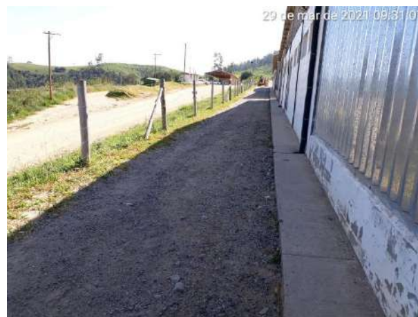
Foto 6 – Limpeza e organização entrada vestiário e sanitários Canteiro Industrial. Data: (29/03/2021)
