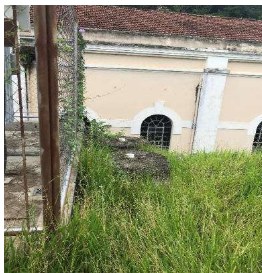
Figura 11.5-15: Caixas coletoras ao lado dos transformadores.
