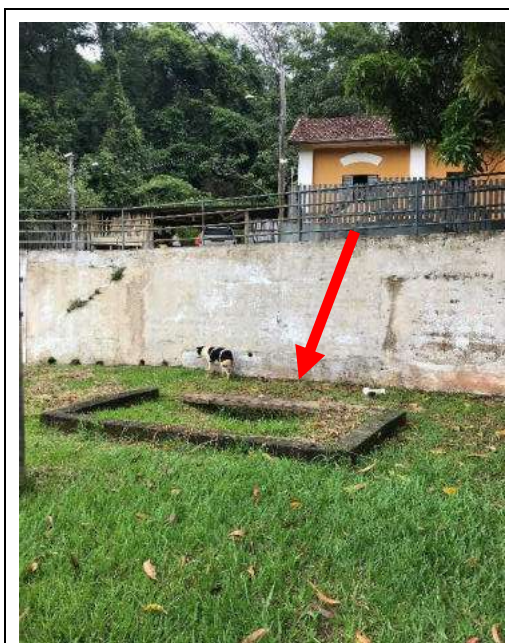
Figura 11.5-1: Fossa séptica, seta indicando o local de afundamento de solo.
