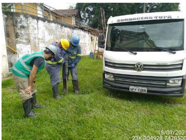
Foto 13 – Acompanhamento do desenvolvimento de sondagens ambientais. (Data: 15/01/2021).
