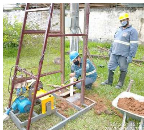
Foto 16 – Desenvolvimento de poço de monitoramento. (Data: 15/01/2021).
