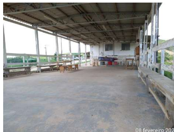
Foto 4 – Limpeza e organização na área de vivência no canteiro operacional. Data (08/02/2021)
