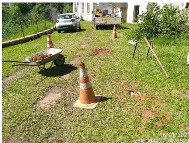
Foto 17 – Desenvolvimento de poço de monitoramento. (Data: 16/01/2021).
