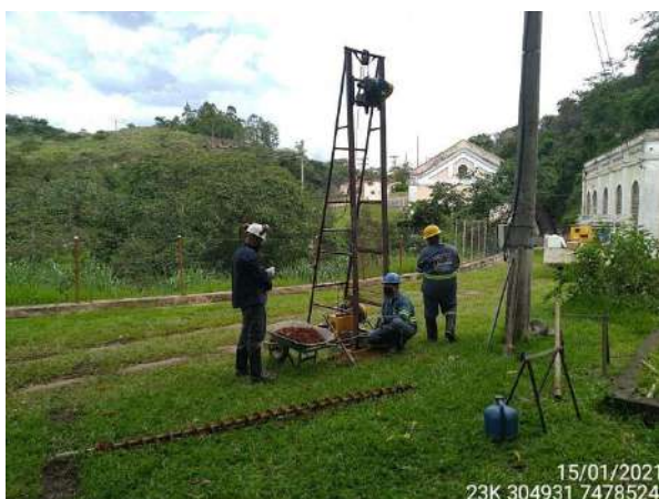
Foto 15 – Desenvolvimento de poço de monitoramento. (Data: 15/01/2021).
