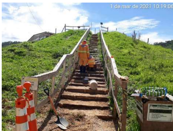
Foto 5 – Trabalhadores fazendo manutenção na escada de acesso ao canteiro industrial, após a ocorrência de chuvas. Data: (01/03/2021)
