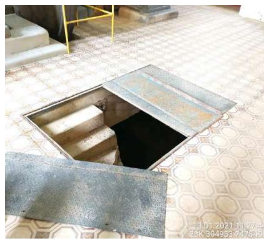
Foto 10 – Avaliação dos edifícios, antes do início das atividades, na Central Hidroelétrica. (Data: 13/01/2021).
