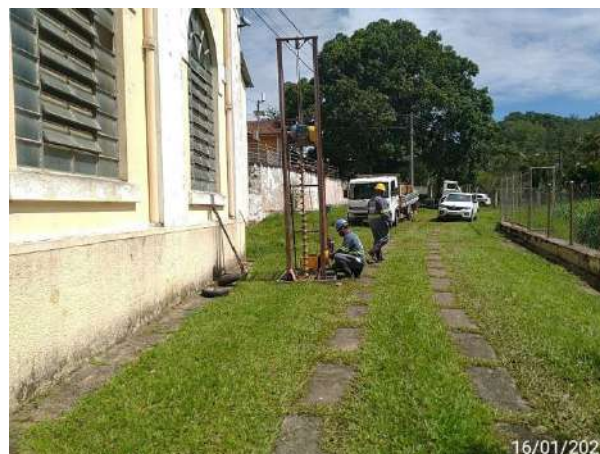
Foto 18 – Desenvolvimento de sondagens ambientais. (Data: 16/01/2021).
